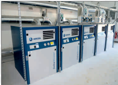
Dmychárna / blower house
